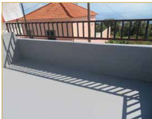
Impermeabilização de terraço numa moradia na rua das Murteiras.
