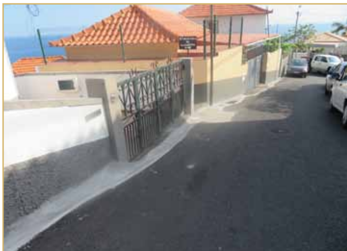
Cimentação de levada no beco da Levada do Lazareto.
