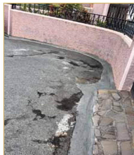
Cimentação de levadas e bermas da 3.ª travessa do Transval.
