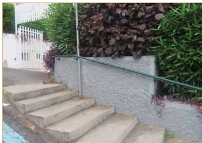
Pintura de corrimão na rua da rochinha, junto ao Colégio Salesianos.
