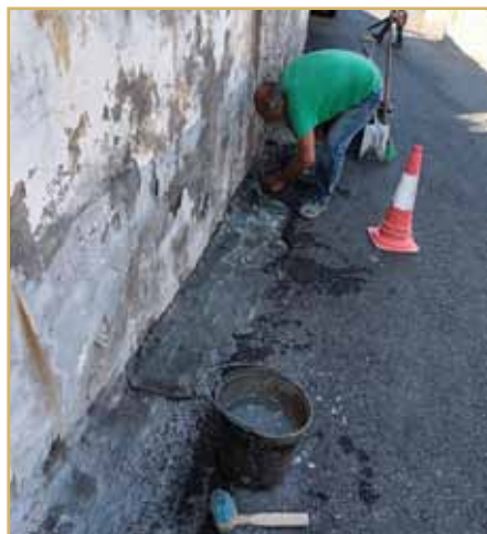
Cimentação de berma da rampa Conde Carvalhal e da travessa do Lombo da Boa Vista.
