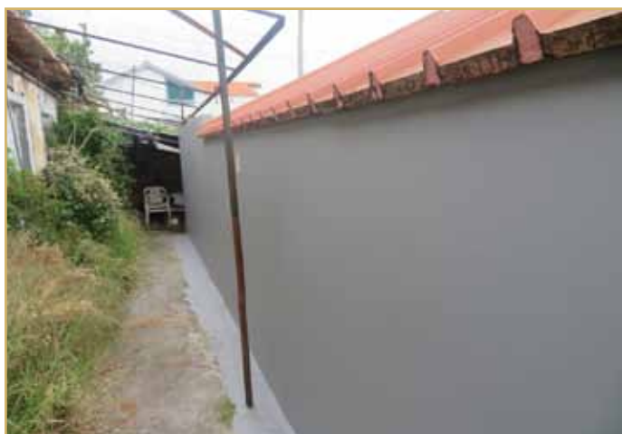
Impermeabilização de parede exterior numa moradia situada no caminho do Terço.
