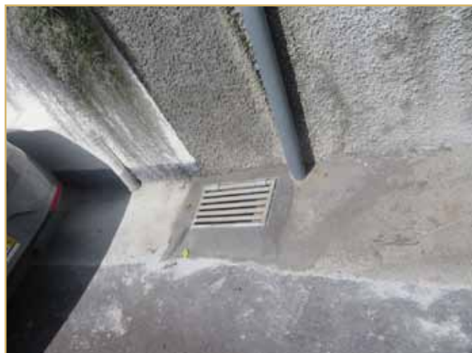
Colocação de grelha na estrada Conde Carvalhal.
