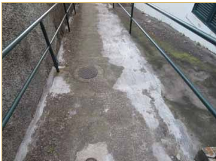
Reparação dos degraus e piso na rampa da Escola Salesiana.
