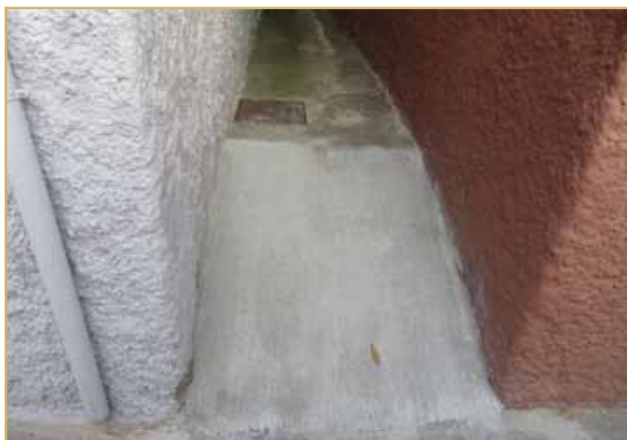
Construção de uma rampa de acesso no bairro Santa Maria.
