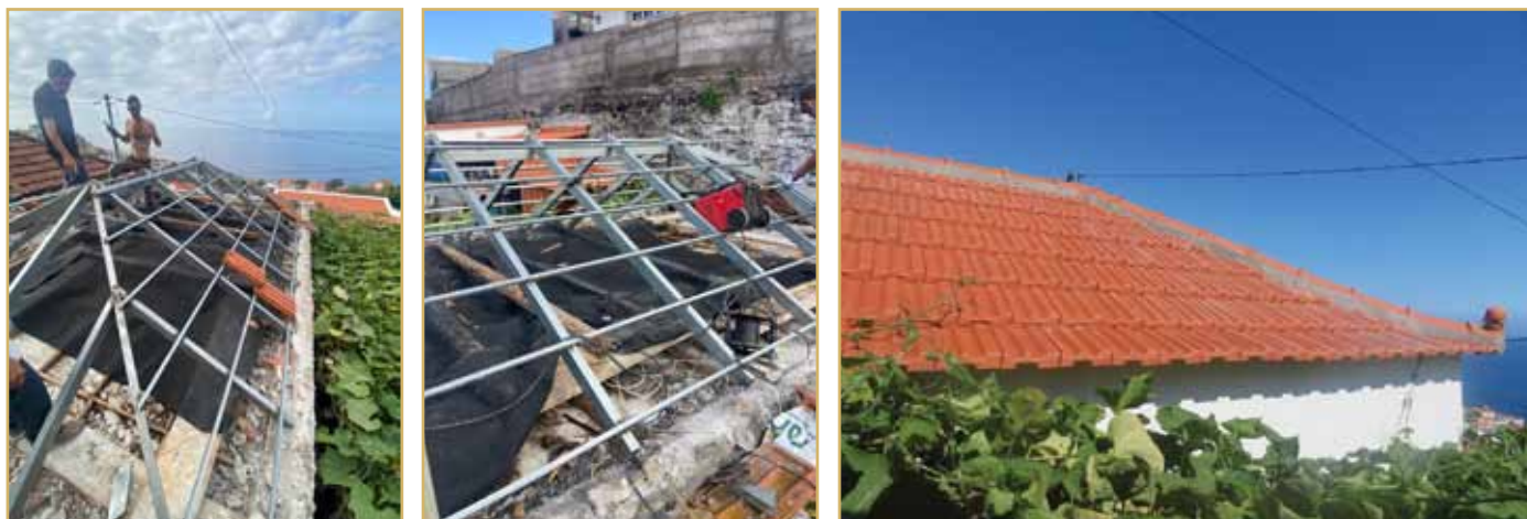
Reparação de telhado e substituição de travejamento de madeira para ferro, numa habitação no beco do Pasto.
