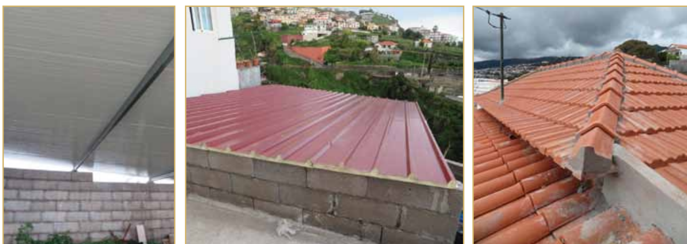
Construção de alpendre numa habitação no beco do Tobias.
