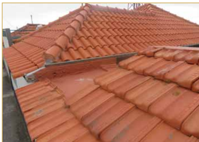
Impermeabilização de telha numa habitação na travessa das Murteiras.
