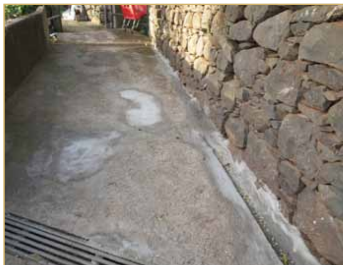
Cimentação de piso na travessa do Transval.
