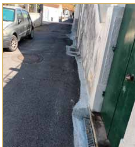
Cimentação de berma da rampa Conde Carvalhal e da travessa do Lombo da Boa Vista.
