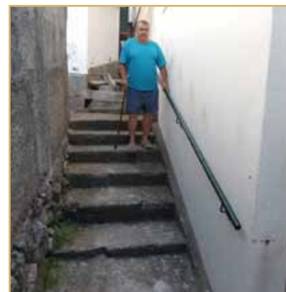
Colocação de corrimão na entrada 42 na rua Clube da Choupana.
