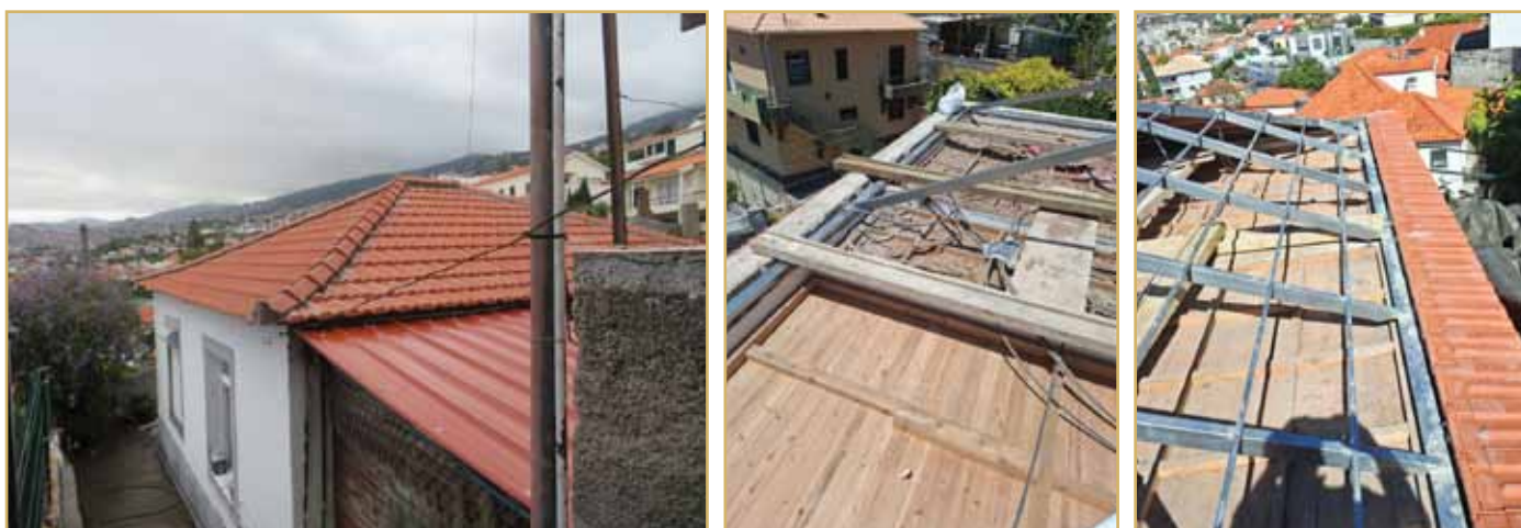
Reparação de telhado e substituição de travejamento de madeira para ferro, numa habitação na travessa da Boa Vista.
